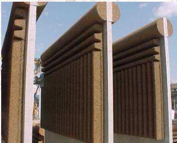
Amélioration de la diffraction du bruit dans la zone d'ombre de l'écran par l'installation d'un couronnement acoustique en béton de bois
