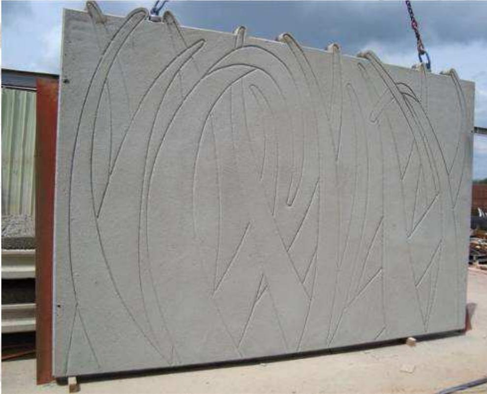
**Finition avec béton imprimé**
