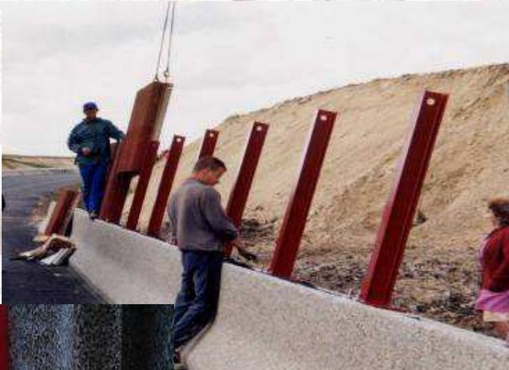
Inclinaison des écrans sur GBA à 15% suivant la recommandation du SETRA (dégagement du cône de sécurité)
